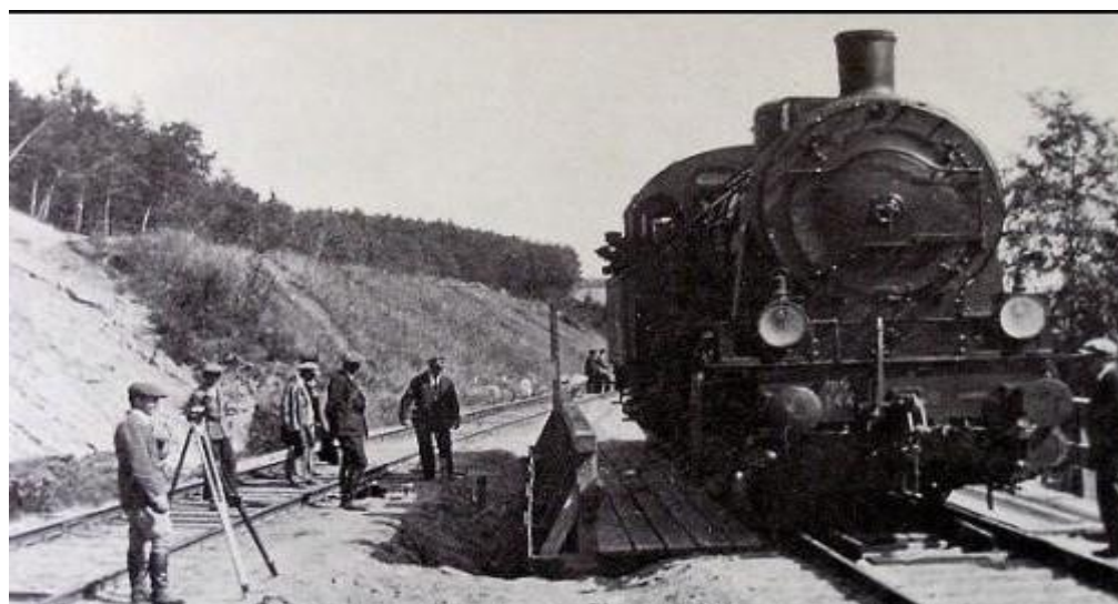
Prace przy linii kolejowej w rejonie Małego Kacka
